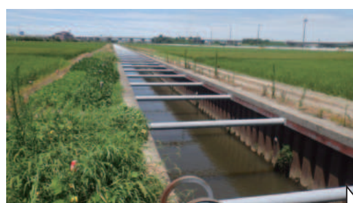
鋼矢板護岸の農業用排水路
