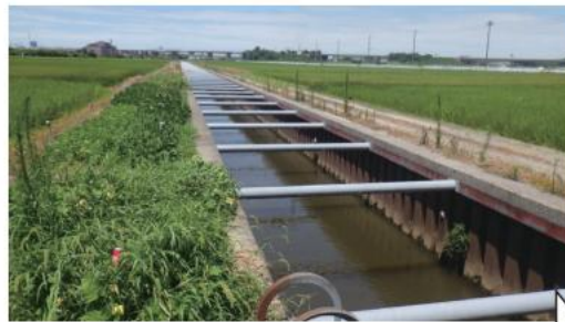
鋼矢板護岸の農業用排水路
