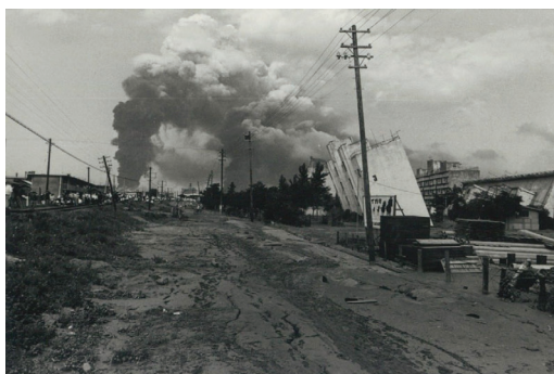
新潟地震における液状化で傾いた団地(写真:新潟県)
