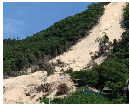
能登半島地震によって珠洲市において発生した地すべり
