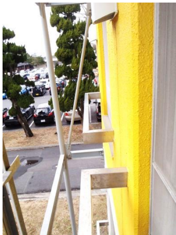
窓の外 (手すり)
