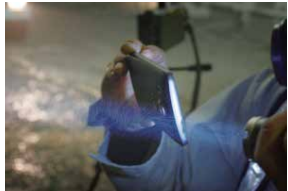
トンネル坑内で粉じん測定をしている状況。LEDライトを当てると浮遊粉じんが光に散乱し白く光っているのがわかります。
