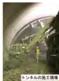
トンネルの施工現場
