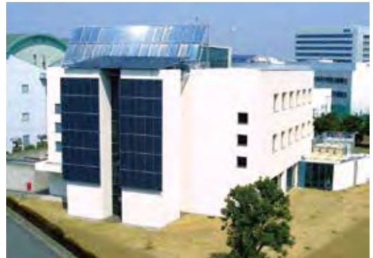
日本初の改修によるZEB建物。屋上には太陽光発電や太陽熱集熱器を設置
