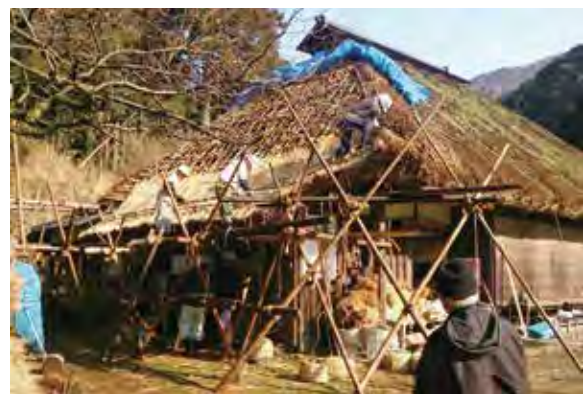
山口県下関市の伝統民家で現在も行われている茅葺屋根葺き替え作業への参加調査の様子(2014年3月)
