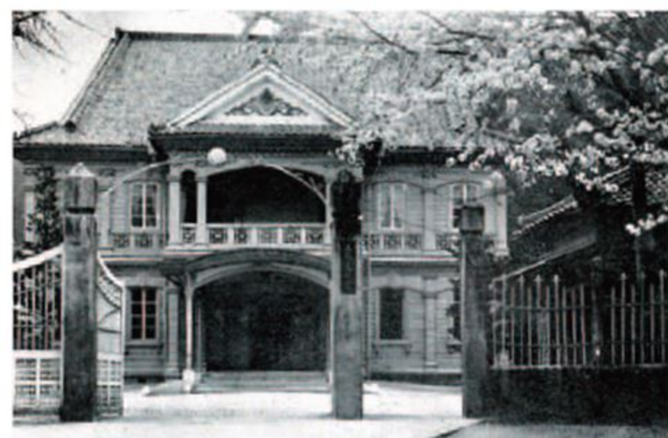
旧旧山高から引き継いだ校舎本館
