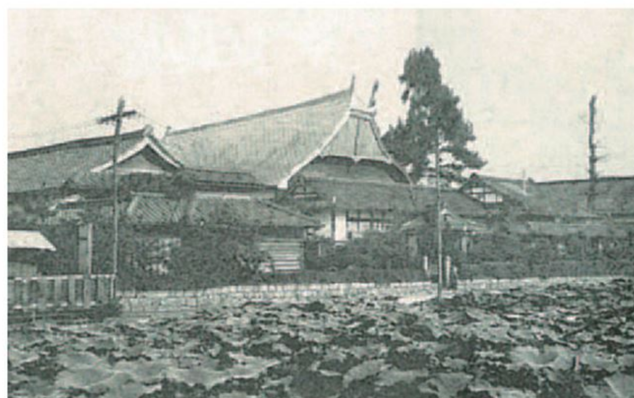
山口高等獣医学校仮校舎（小郡高等女学校校舎）
