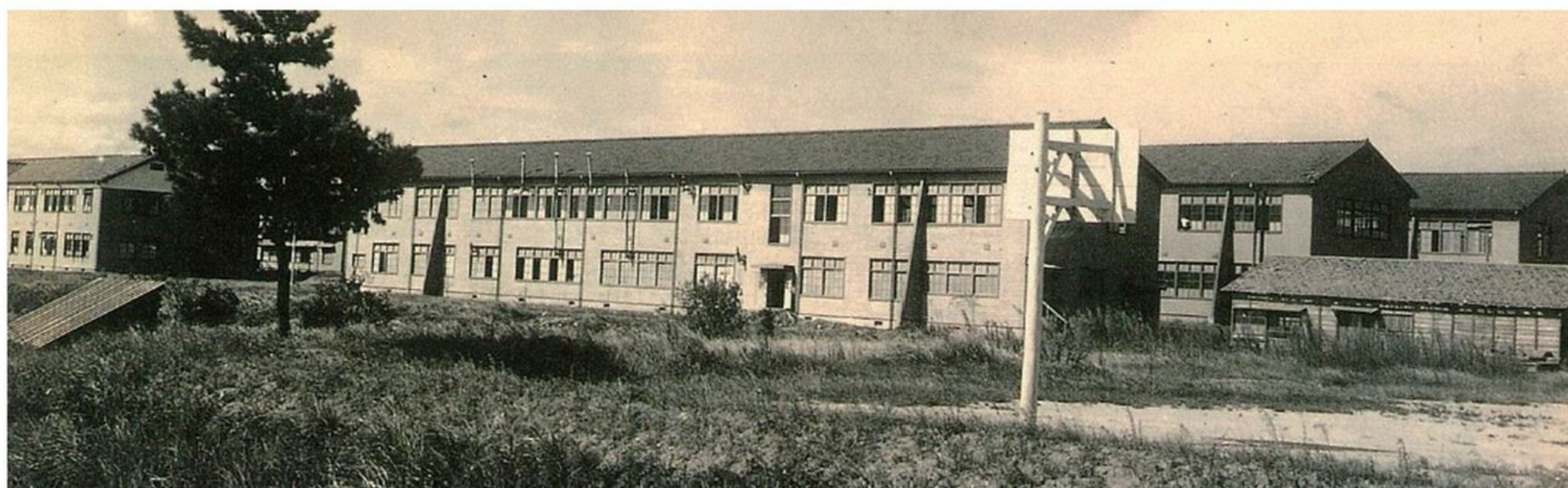
完成した新校舎
