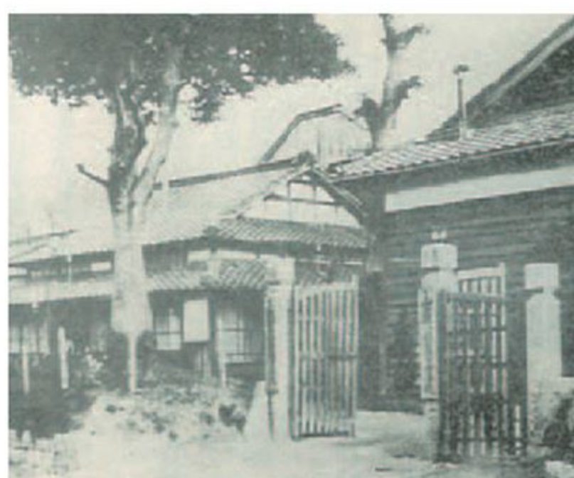
山口高等獣医学校仮校舎（小郡高等女学校校舎）
