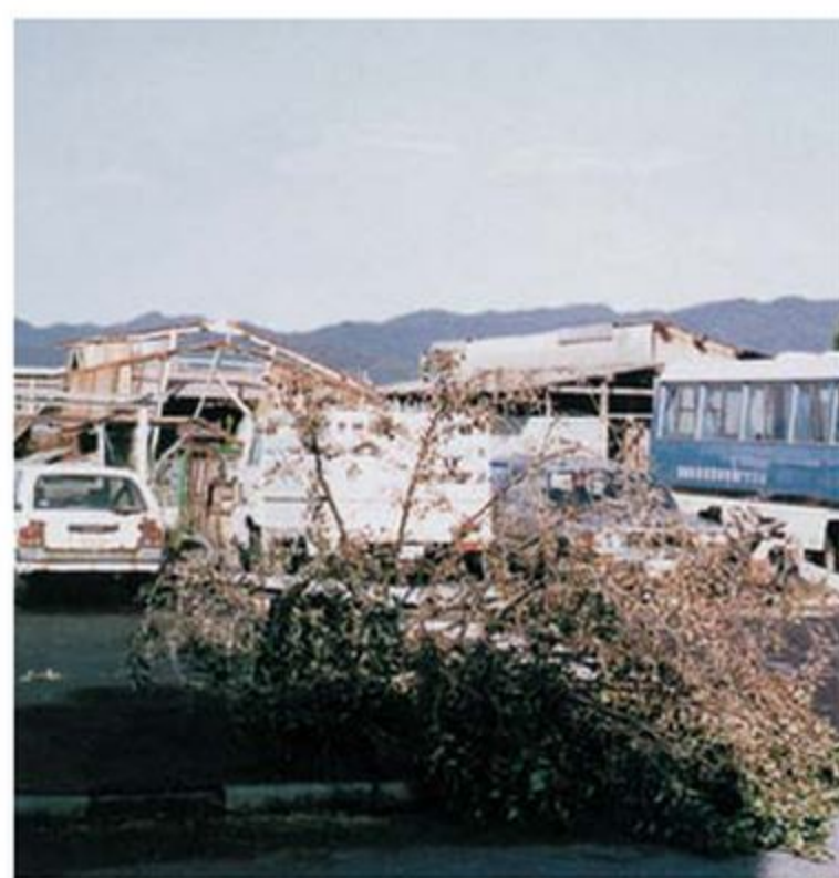
平成3年(1991.9.28) 台風19号被害状況 家畜病院車庫付近
