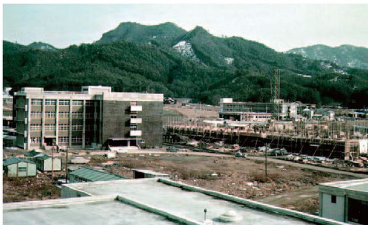
昭和42(1967)年 農学部と建設中の文理学部
