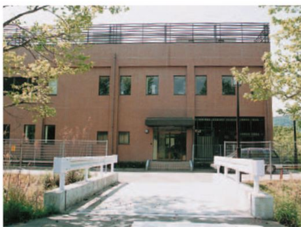
平成8年(1996.3.26) 新放射性同位元素総合実験室落成
