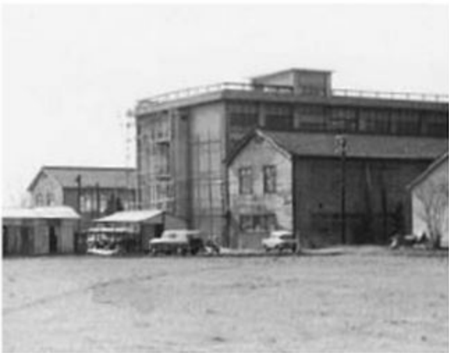
建設中の工学部本館
