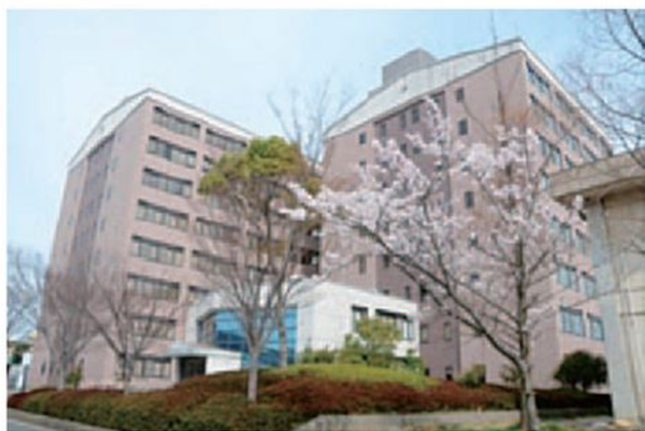
工学部電気電子棟・機械・社建棟
