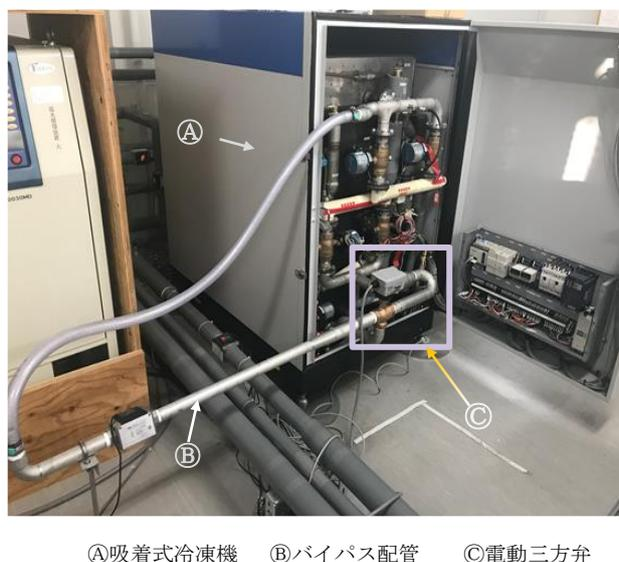
図 3. 吸着式冷凍機の外観
