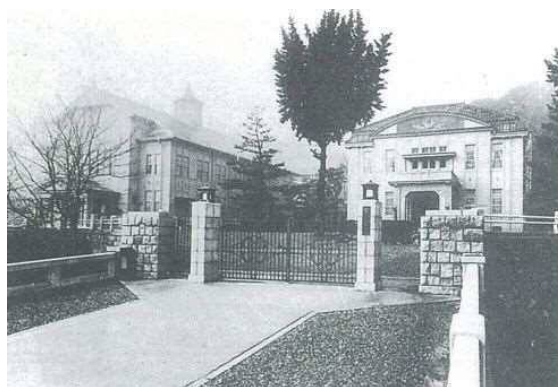
改築後の本館(昭和2年3月新築)
