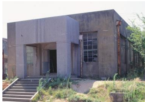
旧徳山海軍燃料廠移管図書を保管していた書庫 当時の工専唯一の不燃性の建物である。
