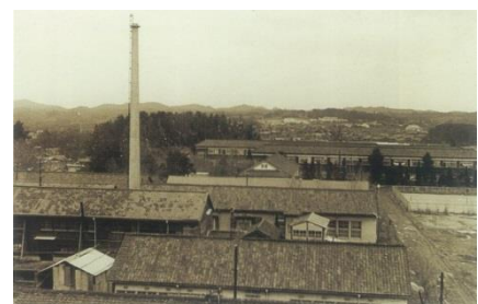
工学部(宇部市常盤台)
