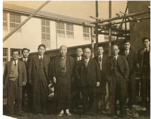
竣工間近の管理棟を視察(昭和31年)
