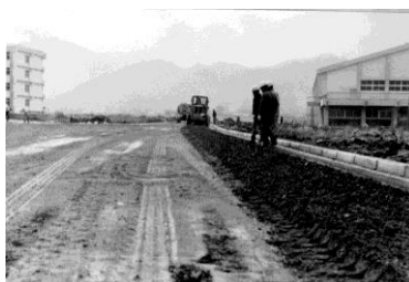
体育館前の道
