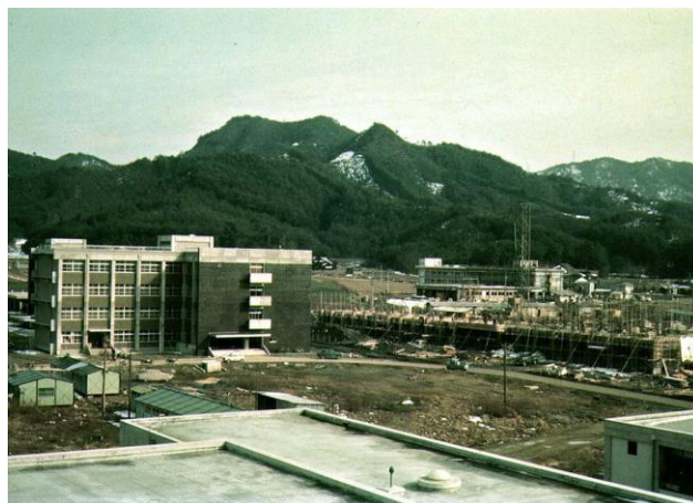
農学部と建設中の文理学部(昭和42年)
