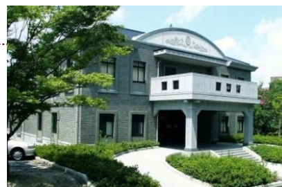
商品資料館竣工 (平成6年12月)
