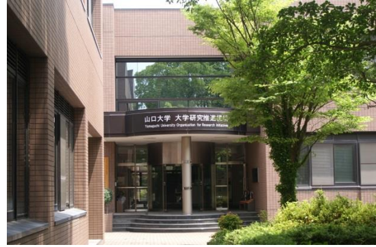
大学研究推進機構建物外観
