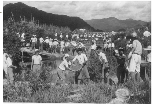
樫野川改修(昭和14年)
