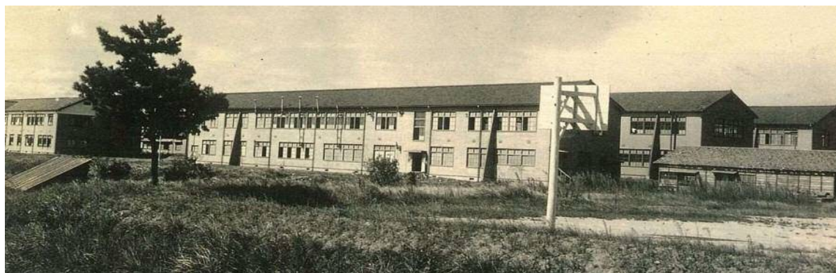
完成した新校舎
