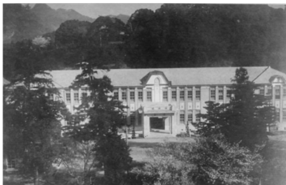
昭和4年に完成した本館
