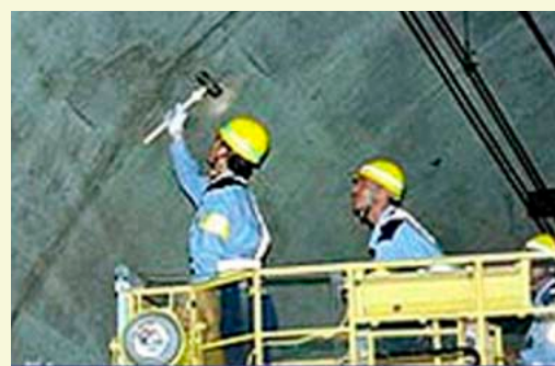
図1．打音検査の様子
