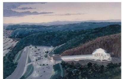
図-1 高山祭りミュージアム（世界で唯一の本格的な人工の岩盤空洞を利用した地下式美術館、空洞直径40m、最小土被り31m、1995年建築評定を取得）
