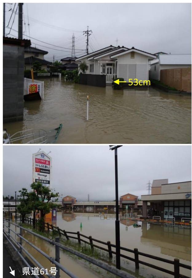
写真 2 田屋島地区における 2023 年豪雨による浸水の状況（上：新興住宅地、下：大型商業施設）
