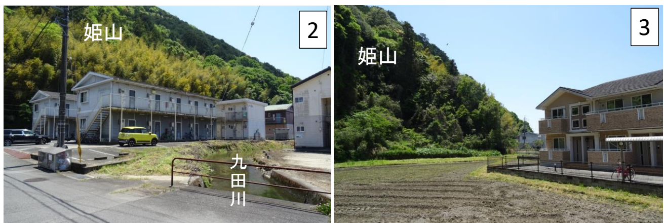
写真 5 姫山東側の土砂災害警戒区域（2025 年 5 月 8 日撮影）
